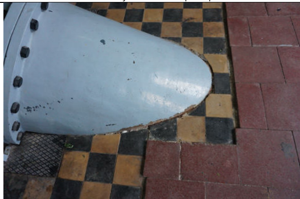
Overgang pompbuis in vloer
