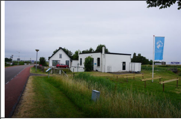
Zicht op het gemaal (rechts) en woning (links)
