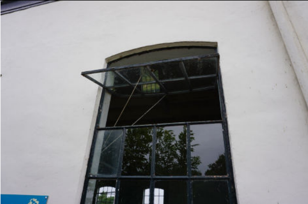
Het meest rechtse venster in de voorgevel (bovenlicht open)
