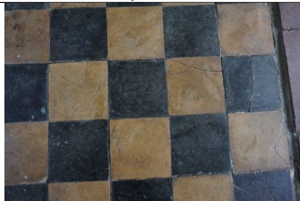
Detail tegelvloer bij installatie
