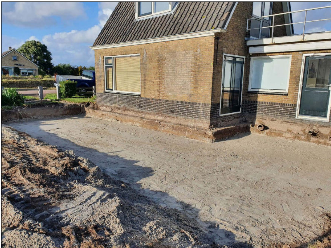
Aan Oost 2 op Texel is de bouwput uitgegraven en aangevuld met zand waardoor archeologische waarnemingen niet meer mogelijk waren.
