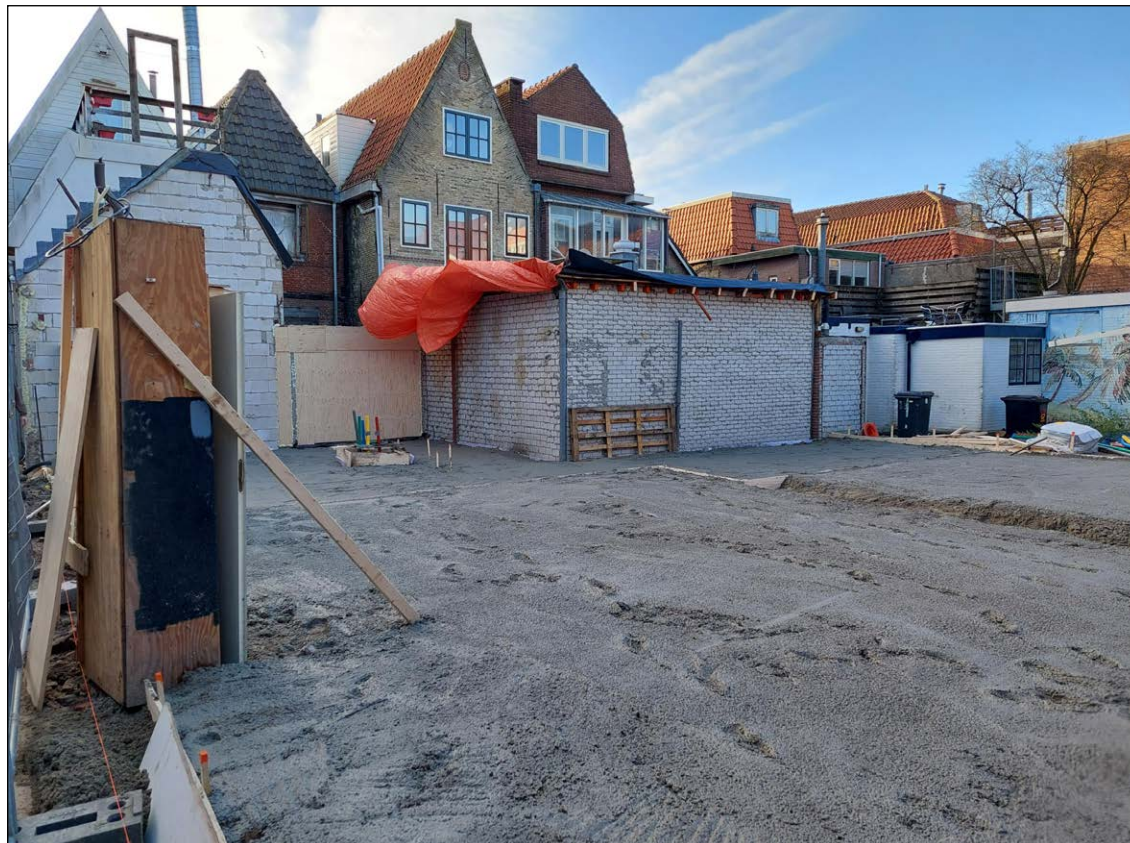
Aan de noordzijde van de Slijkteeg zijn twee panden archeologie-vriendelijk gebouwd met betonvloer.
