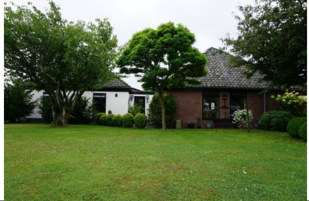
Stelp (rechts) en latere aanbouw (links)
