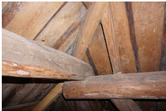
Deel van kapconstructie
