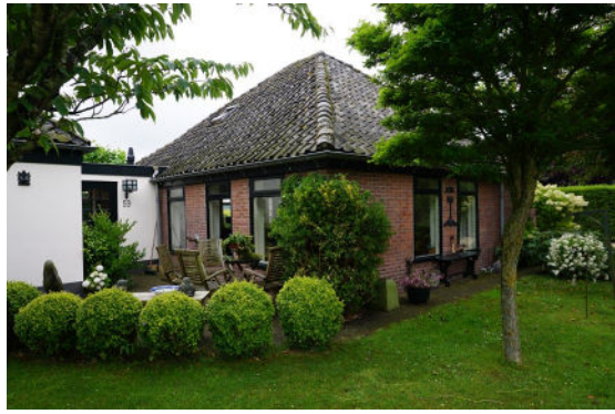
Voorgevel (rechts) en oostgevel (links)
