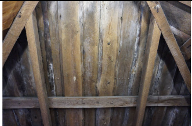
Bepanking kapconstructie
