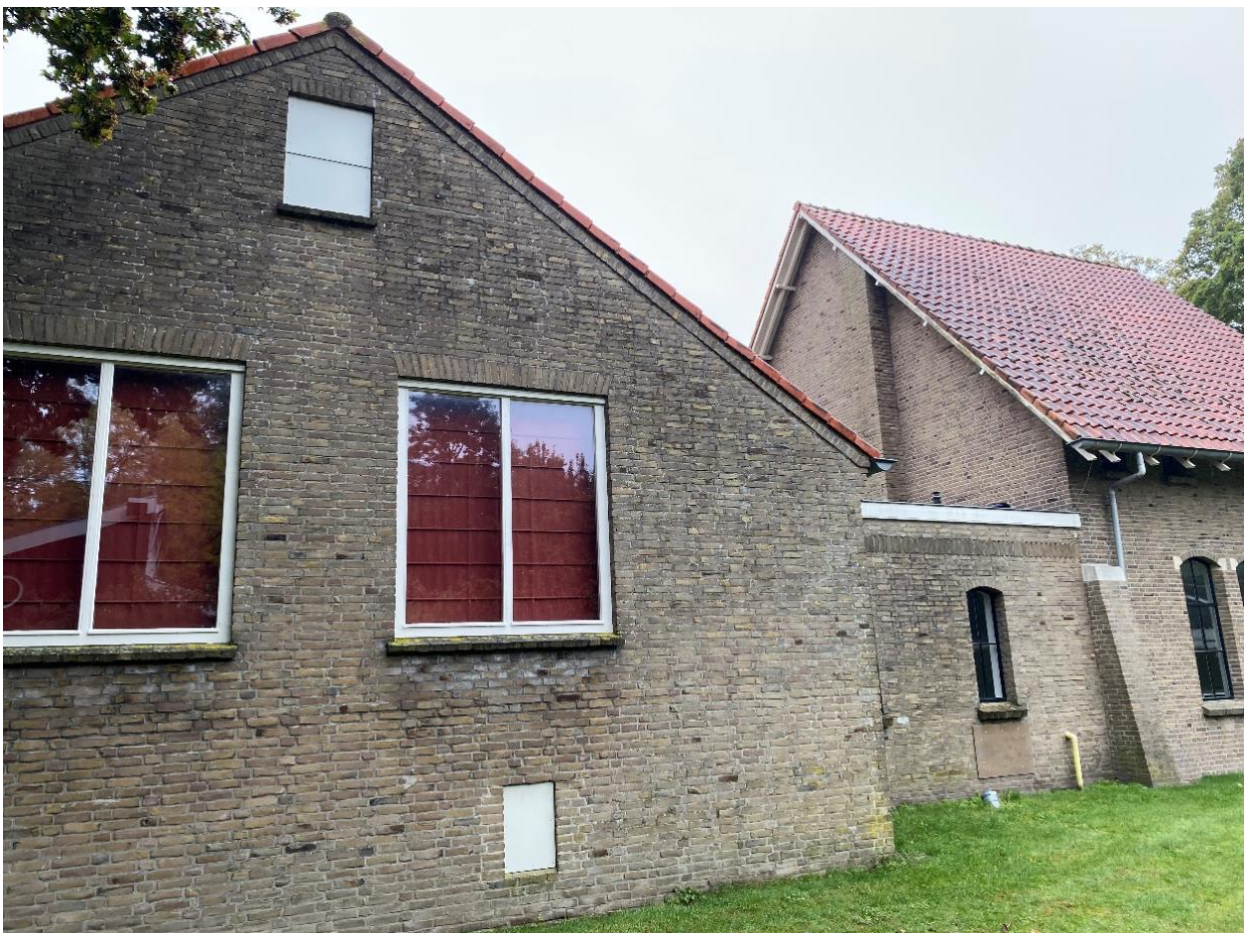
De achtergevel van de toneelzaal en het tussenlid.
