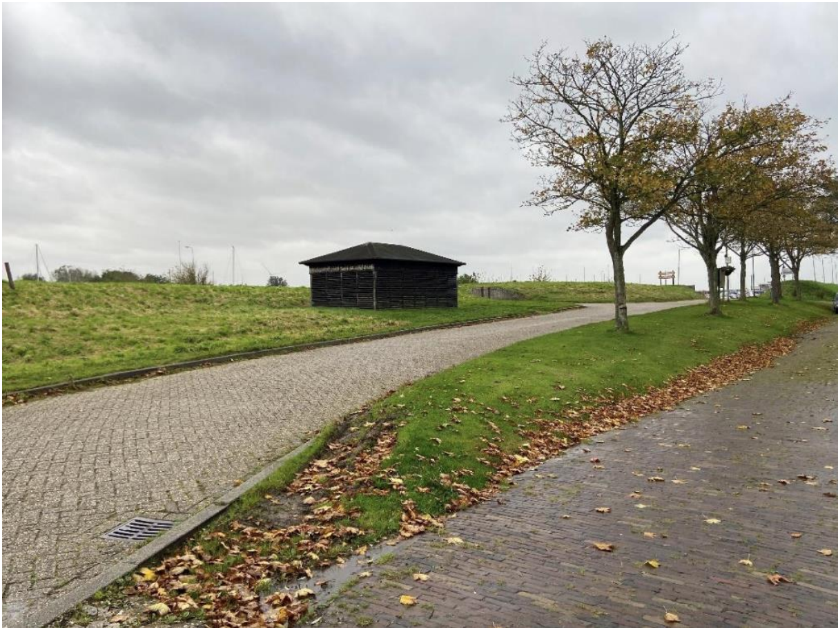
De schotbalkloods in zijn omgeving in de voet van een oude wierdijk en nabij de coupureafsluiting in de dijk.
