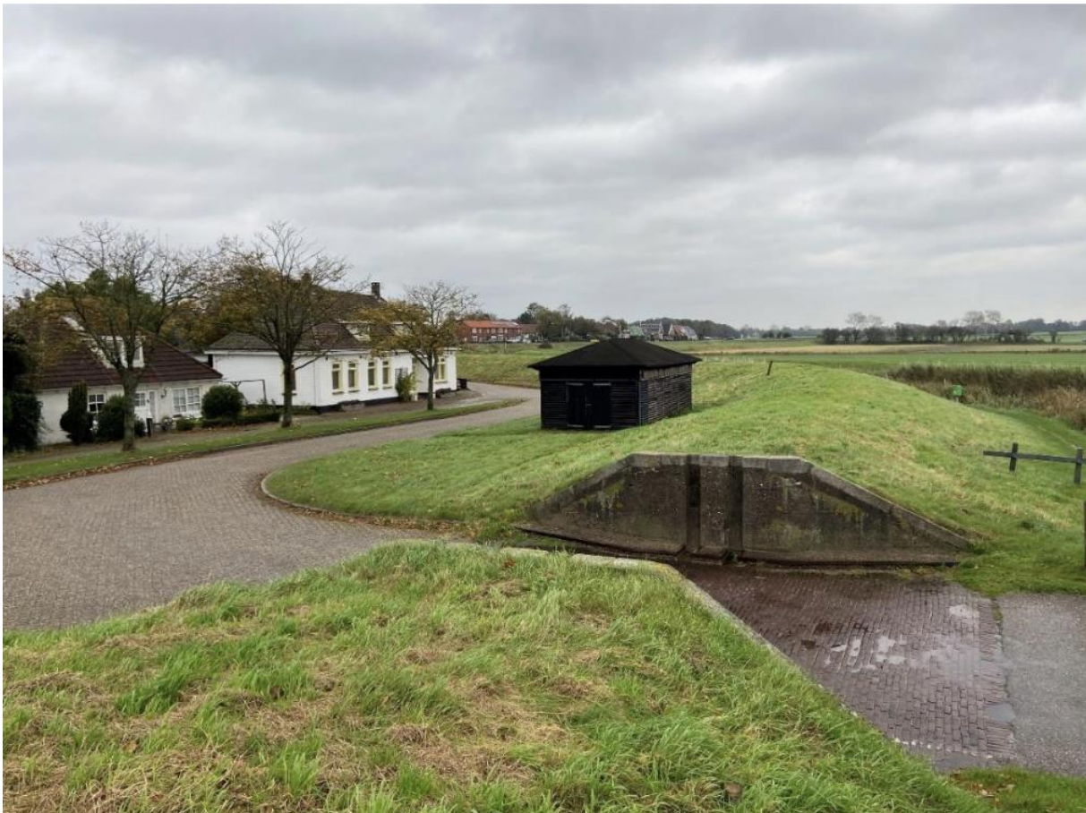
De schotbalkloods in zijn omgeving in de voet van een oude wierdijk en nabij de coupureafsluiting in de dijk.
