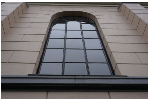
Een van de boogvensters in westgevel
