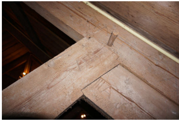
Kapdetail met telmerken en pen-gat verbinding
