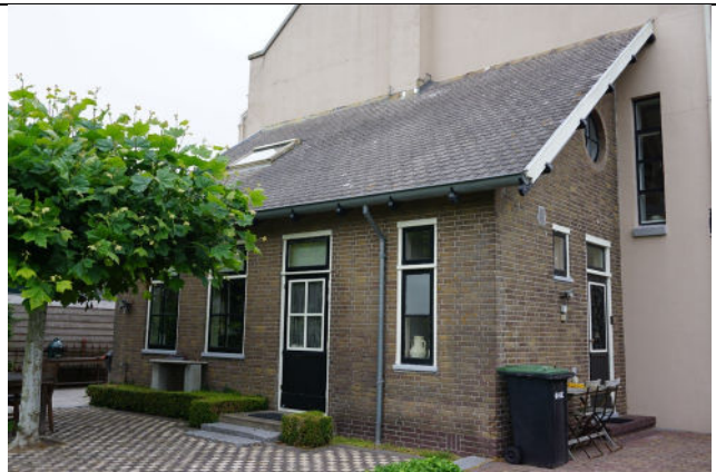
Latere aanbouw aan achterzijde
