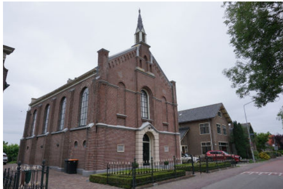
Zicht vanuit het noordoosten
