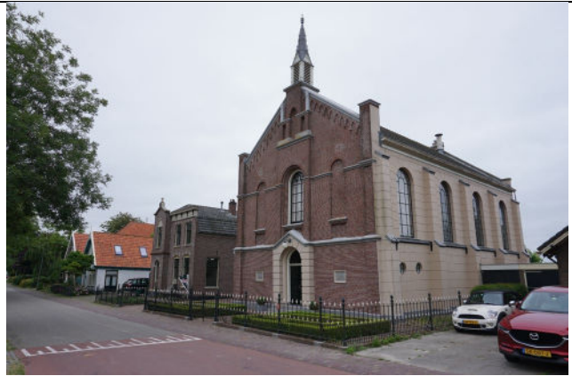
Zicht vanuit het noordwesten
