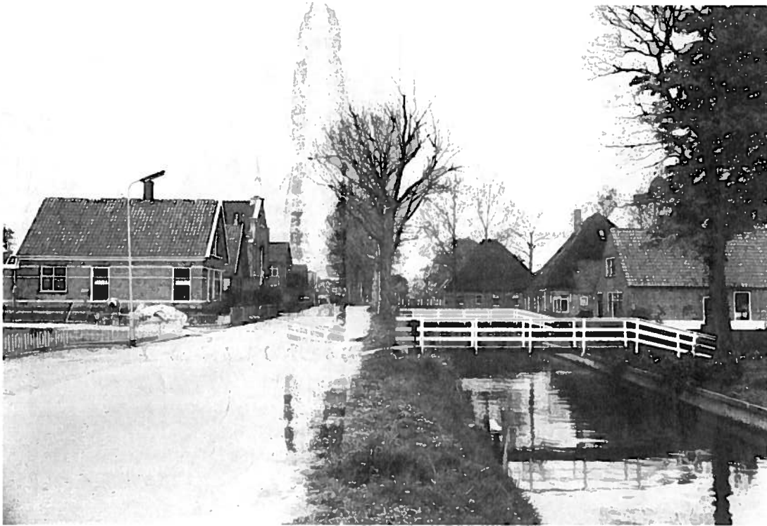
Barsingerhorn, Heerenweg met wegsloot aan de noordelijke voet van de voormalige zeedijk, nabij de T-kruising met de Mieldijk (foto 1983).
