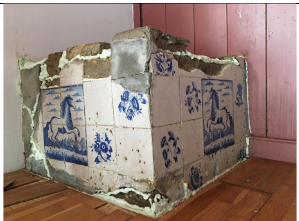
Ombouw opbouw waterkelder met tegeltableaus (foto collectie bewoner)
