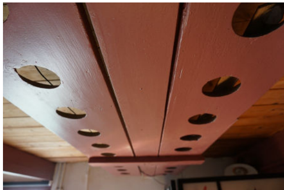
Onderzijde kaasplanken in koeienstal
