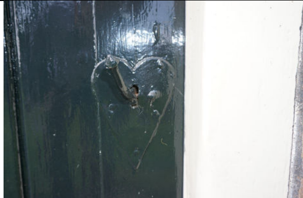
Handgreep in deur naar koeienstal oostgevel
