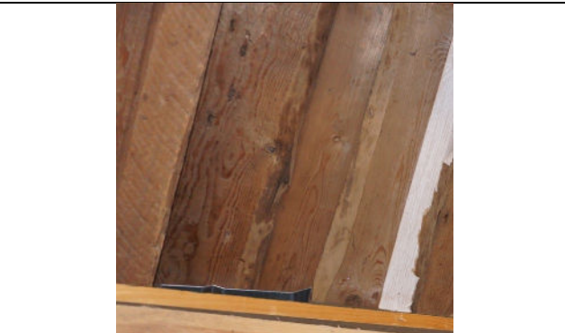
Interieur detail ruw gezaagde beplanking dakvlak
