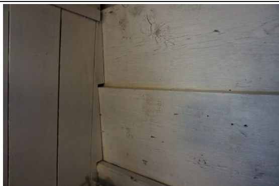
Interieur detail gepotdekselde wand
