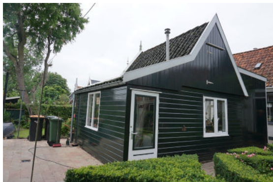
Zuidoostgevel (links) en noordoostgevel (rechts)
