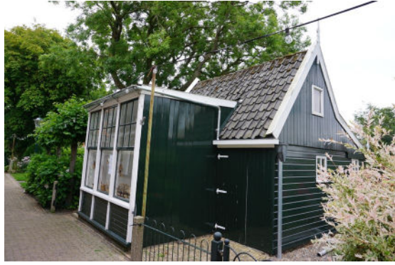
Noordwestgevel (links) en zuidwestgevel (rechts)
