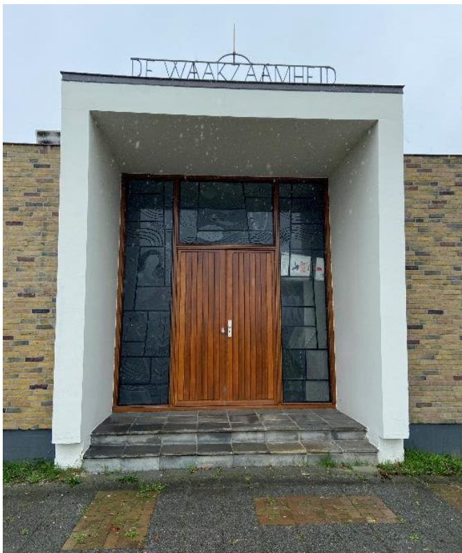
De voorgevel en een detailfoto van de entreepartij.
