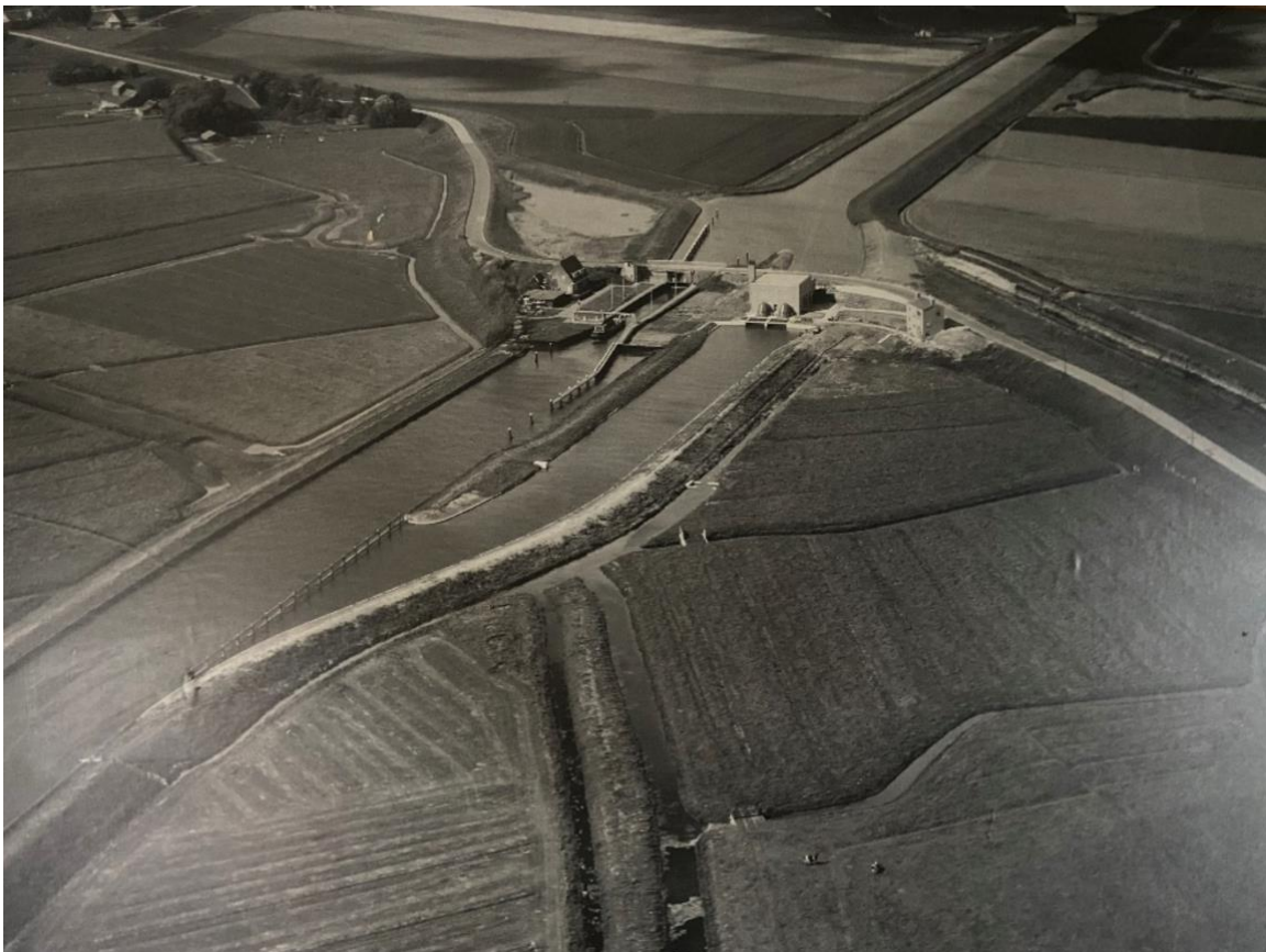
Historische luchtfoto met daarop het boezemgemaal De Waakzaamheid met links het sluiscomplex en rechts de machinistenwoning.
