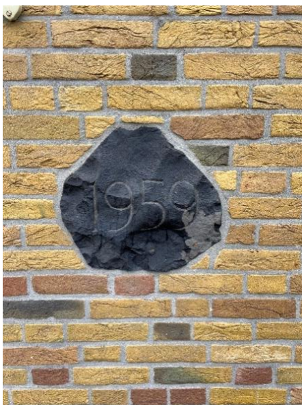
De linkerzijgevel en de eerste steenlegging.
