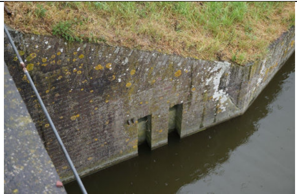
Schotbalksponningen in vleugelmuur binnenfront
