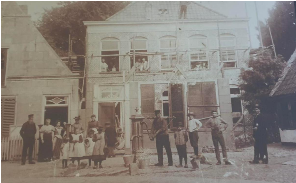
De pastorie in aanbouw. Datum 1898. Een gedeelte van de voorgevel van de 'oude' pastorie staat nog overeind.
