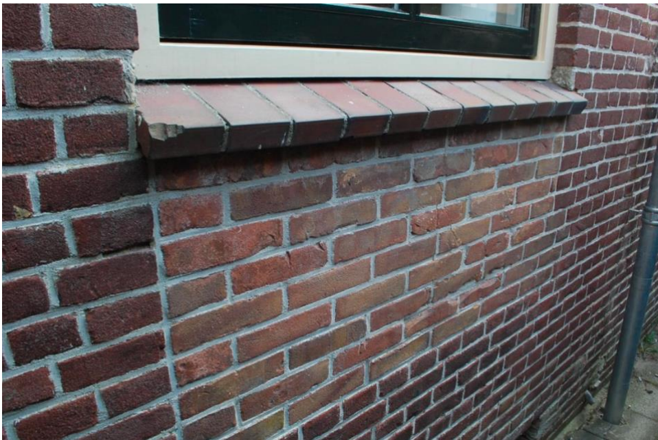
De linkerzijgevel en een detailfoto van het bouwspoor onder het keukenraam.
