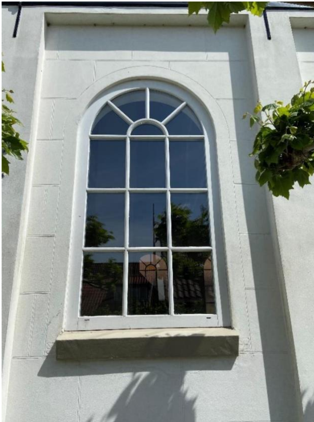
Rechtergevel met een detailfoto van het vernieuwde rondboogvenster.
