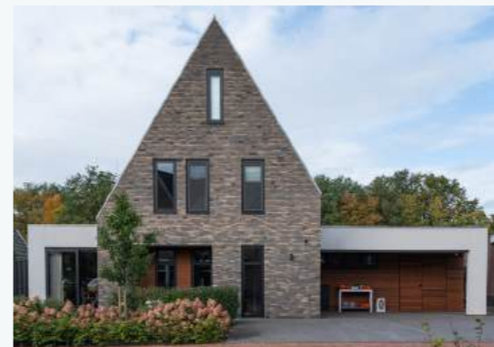
Een woning met een verhoogde goot. Bron afbeelding: bouwvanpijkeren.nl
