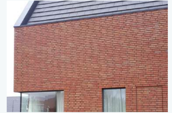
Moderne detaillering van dakrand en hoekoplossing geeft karakter aan de woning.
