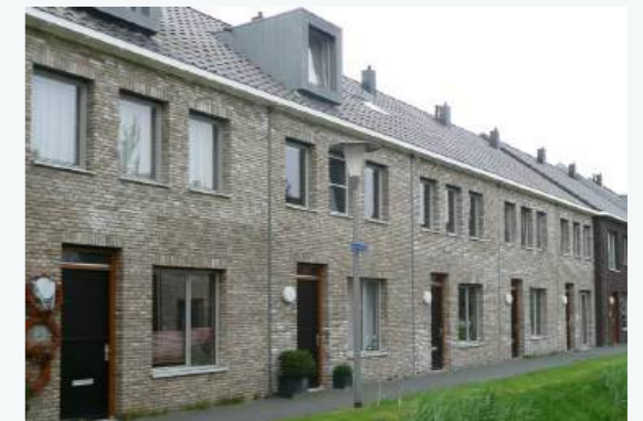
Heldere ritmiek van de gevelindeling.
