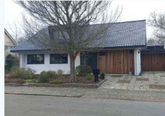
Hoofdvorm 1 bouwlaag met een kap
