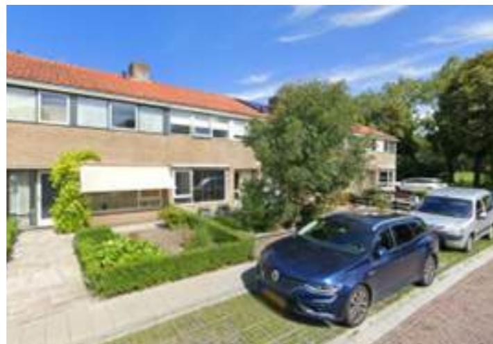
Bestaande bebouwing aan de Karel Doormanstraat. Afbeelding Google Streetview
