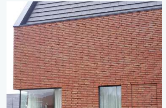
Moderne detaillering van dakrand en hoekoplossing geeft karakter aan de woning.
